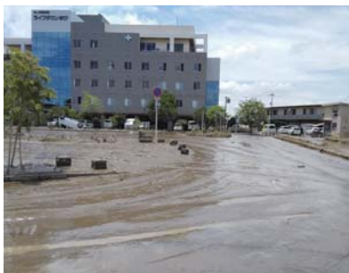
倉敷市（吉備真備駅周辺）
