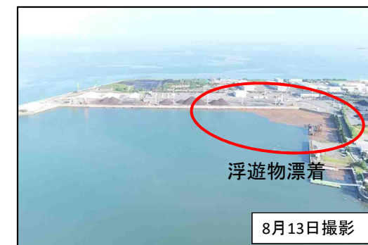
三池港（大牟田市） 内港北地区 泊地 浮遊物漂着 A \approx 20,000\text{m}^2 、 V \approx 3,000\text{m}^3
