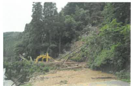
林地の損壊（八女市上陽町）
